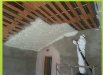
Green house-д байрлах хувийн сууцны өргөтгөлийн дээврийн дулаалга
